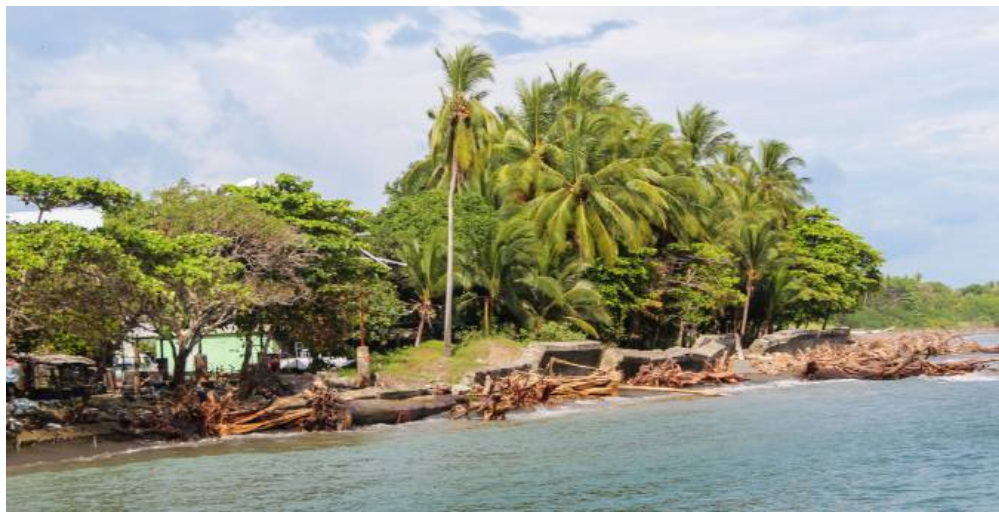
Figura 35. Región Pacífico Occidental. En la Comunidad de Río Mar, Puerto Armuelles, Provincia de Chiriquí, se observa la colocación de muros de contención para controlar la entrada del mar a tierra firme.
